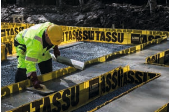
Form fundamentowych nie trzeba demontować po utwardzeniu się betonu. Nie powstaną dzięki temu żadne odpady budowlane na placu budowy.
