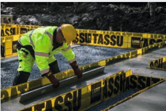
Z pomocą form fundamentowych możliwe jest wykonanie podstawy fundamentu nawet skomplikowanego budynku w ciągu jednego dnia.
